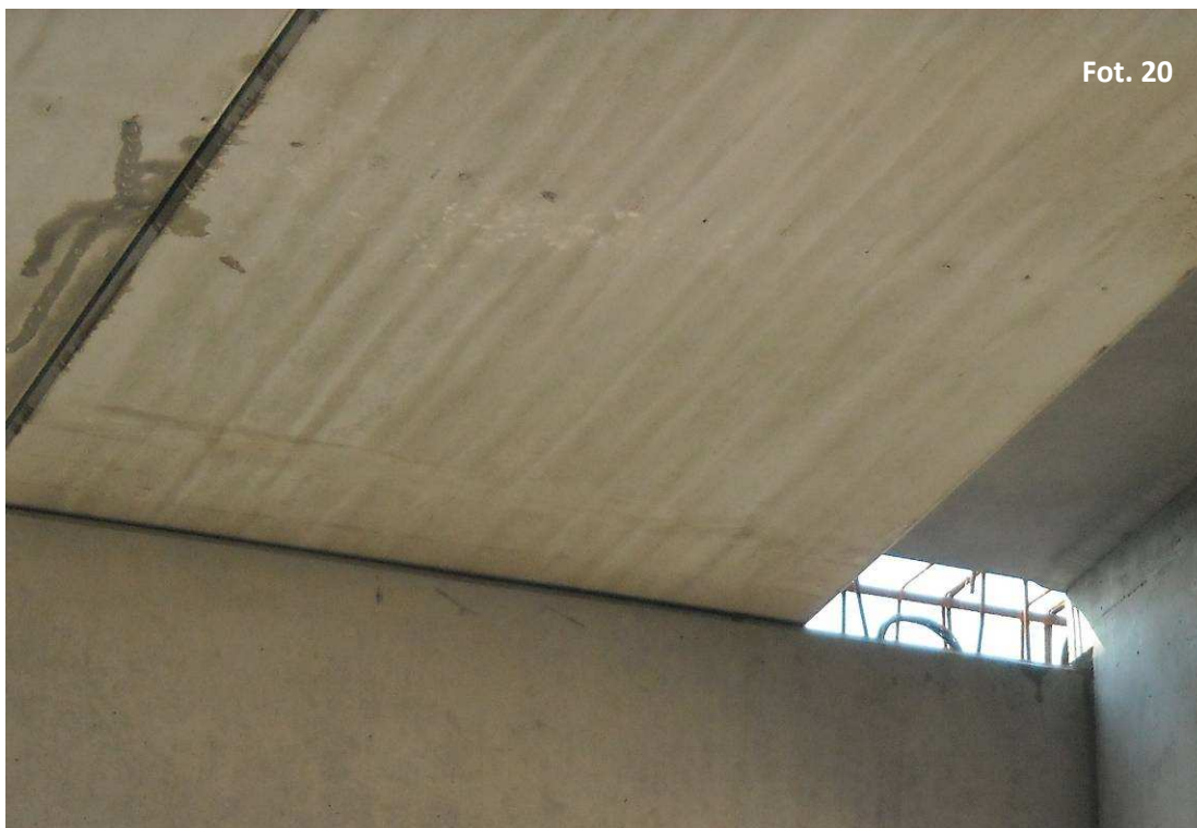
Fot. 20 Widok dolnej powierzchni płyt kanałowych HC z otworami drenażowymi
