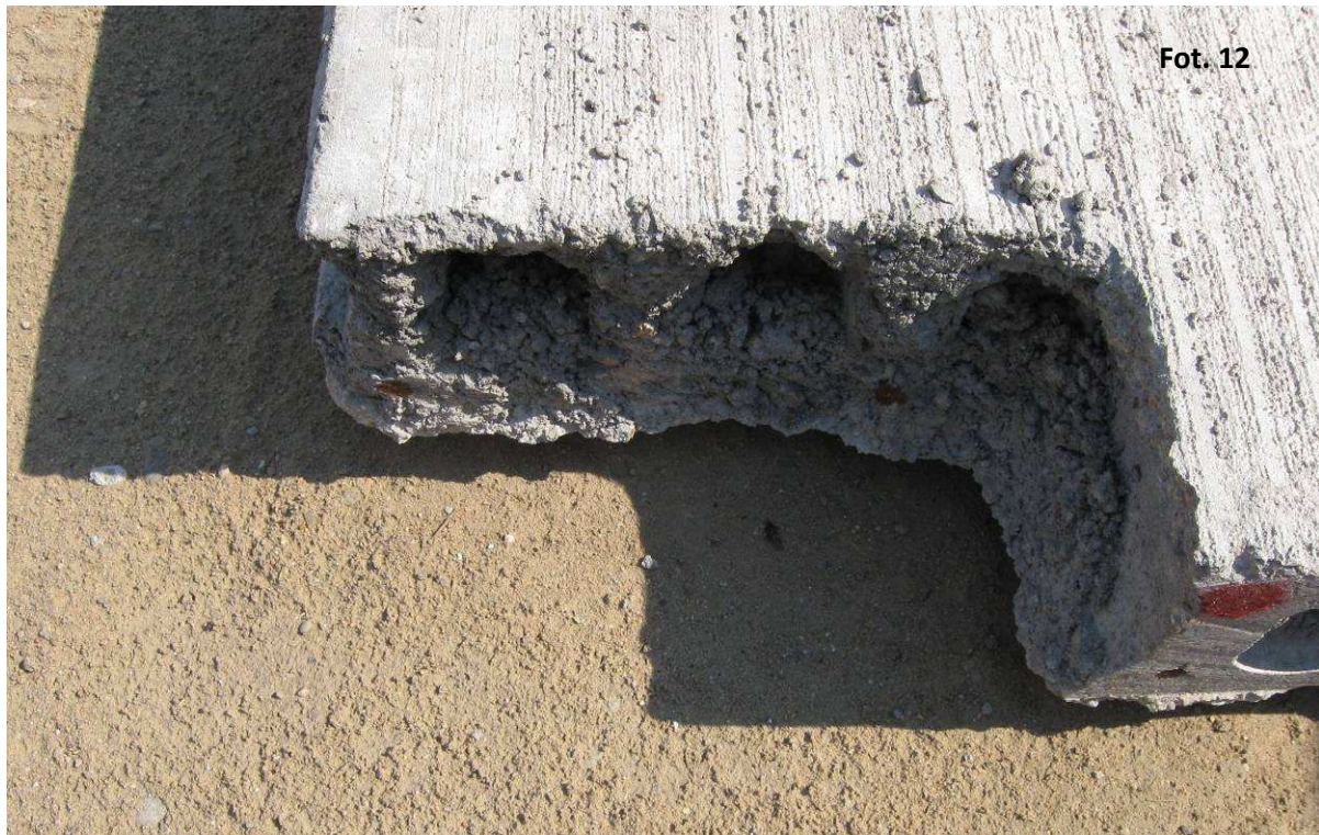
Fot. 12 Wycięcie płyty przy słupie wykonane w mokrym betonie, czyli metodą „na mokro”
