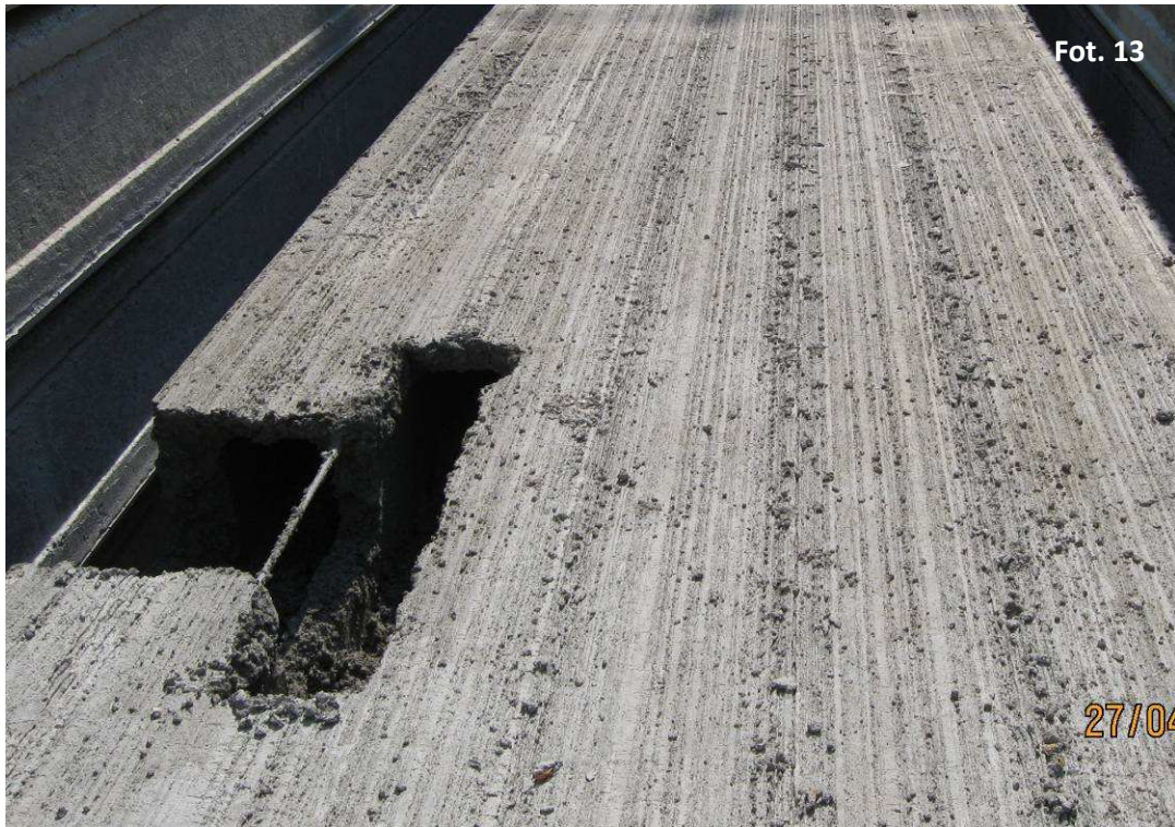
Fot. 13 Widok szorstkiej, górnej powierzchni płyt stropowych
