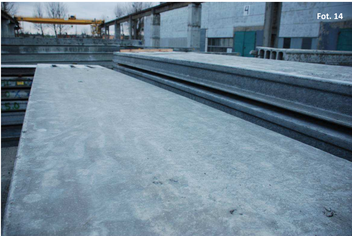
Fot. 14 Widok gładkiej, górnej powierzchni płyt stropowych
