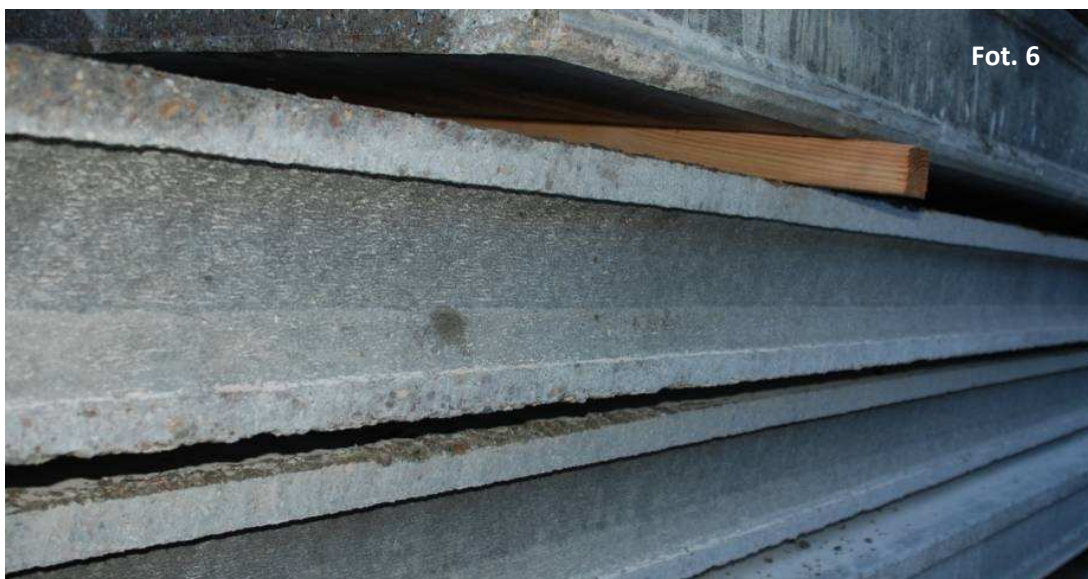
Fot. 6 Wygląd powierzchni bocznej płyty ciętej wzdłuż metodą „na sucho”
