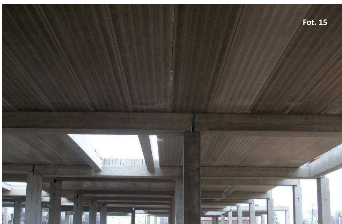
Fot. 15 Widok dolnej powierzchni płyt stropowych
