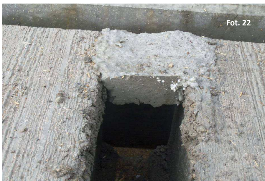
Fot. 21, 22 Przykładowe naprawy płyt HC
