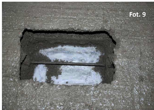
Fot. 8,9 Cięgno lub cięgna pozostawione w otworach na czas transportu i montażu należy usunąć po zamontowaniu płyt. Wycięcie cięgien leży po stronie Zamawiającego
