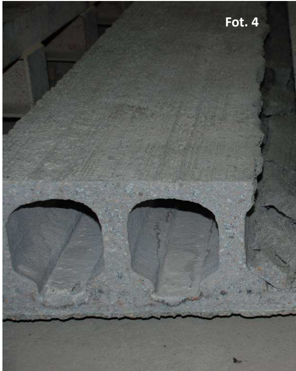
Fot. 4,5 Wygląd powierzchni górnej płyty ciętej wzdłuż metodą „na mokro”
