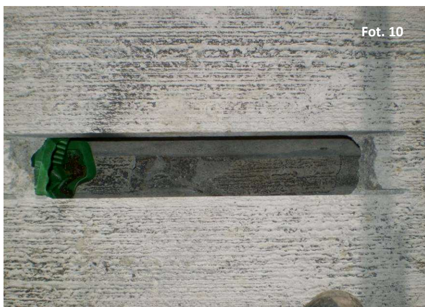
Fot. 10 Otwarty kanał wykonany metodą „na sucho”
